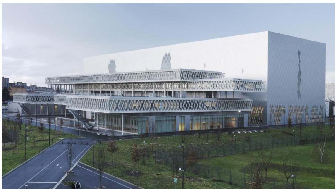
Site de Pierrefitte-sur-Seine des Archives nationales. Son extension par l'agence l'AUC a intégré une dimension environnementale dans les procédés constructifs (performance thermique, orientation au nord des surfaces vitrées...) et a veillé à libérer l'emprise au sol pour préserver les espaces verts. © Archives nationales de France
